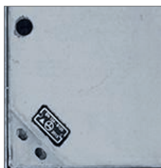
▲ Ocelový poklop vybetonovaný
